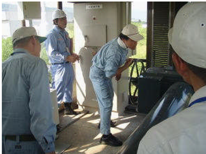
□ H22年8月27日 松節排水樋管(長野市)
