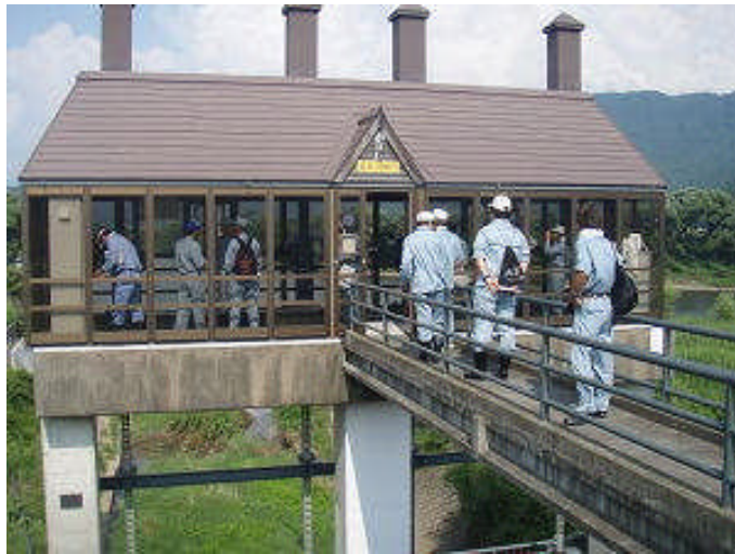
□ H22年8月24日 宮沢川樋門(飯山市)
